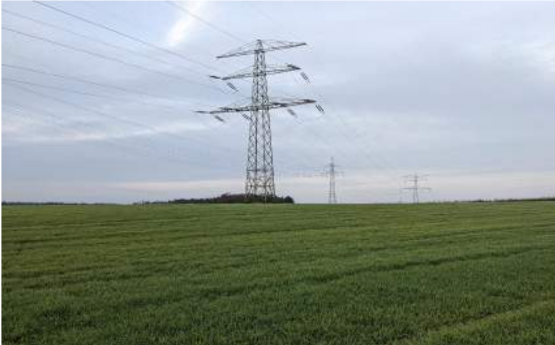
Abb.: Blick von Südost in Richtung Nordwest auf die Teilfläche 4 mit den beiden Freileitungen (eigene Aufnahme 12/2022)
