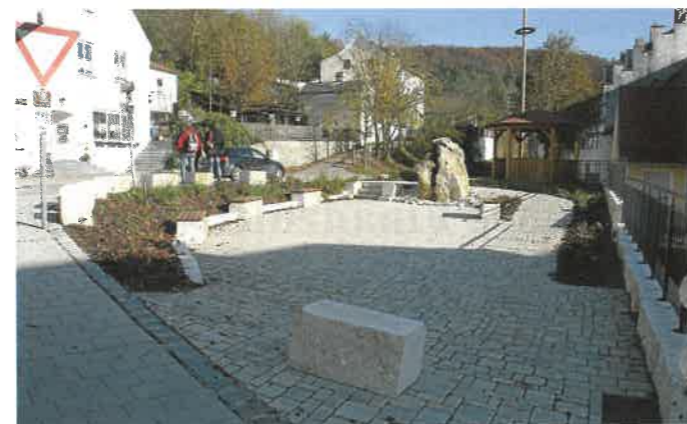
Weitgehend abgeschlossen sind die Arbeiten für die Neugestaltung des neuen Dorfplatzes in der Ortsmitte von Schamhaupten. Foto: az
