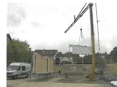
Die ersten Fertigbauteile schweben über die Fläche, um montiert zu werden.
