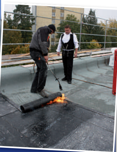
Vorarbeiter Göpfrich erhitzt die Bitumenschicht, so verschweißt sich die Dachpappe optimal. Der Chef begutachtet die Arbeit.
