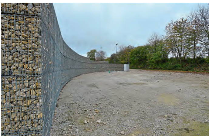
Das neue Baugebiet mit Gabionenwand (Geländer)
