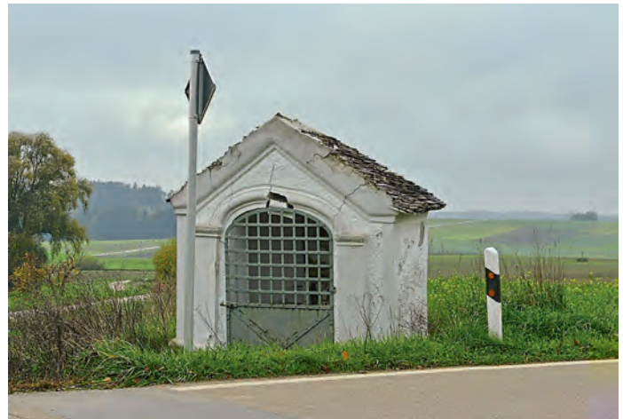
Baufällige Kapelle bei Laimerstadt
