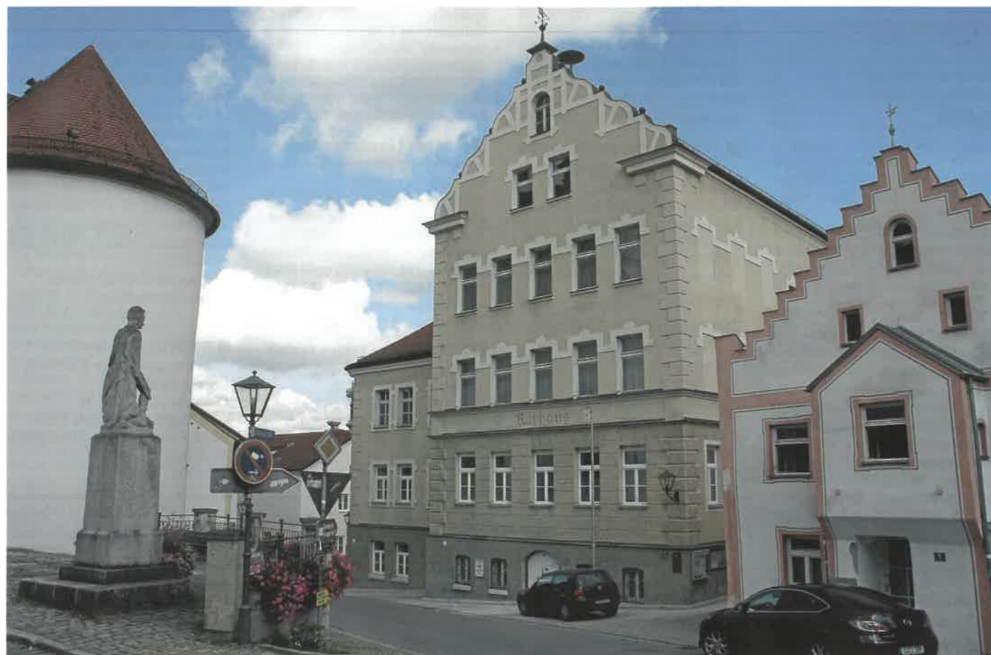
Außen ist gegenwärtig von den Arbeiten wenig zu sehen. Zu erkennen ist, dass die Fenster im Erdgeschoss und ersten Obergeschoss schon erneuert sind. Foto: oH
