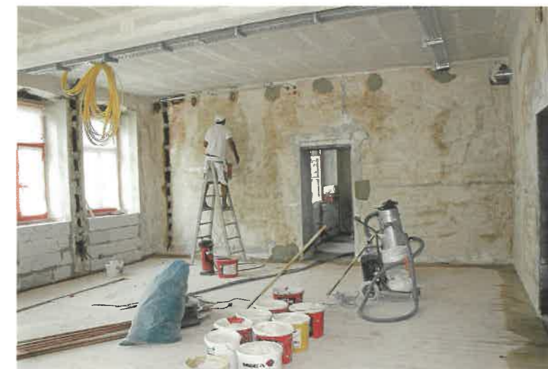
Mit Hochdruck wird gegenwärtig in nahezu allen Räumen des ersten Obergeschosses gearbeitet Foto: oH
