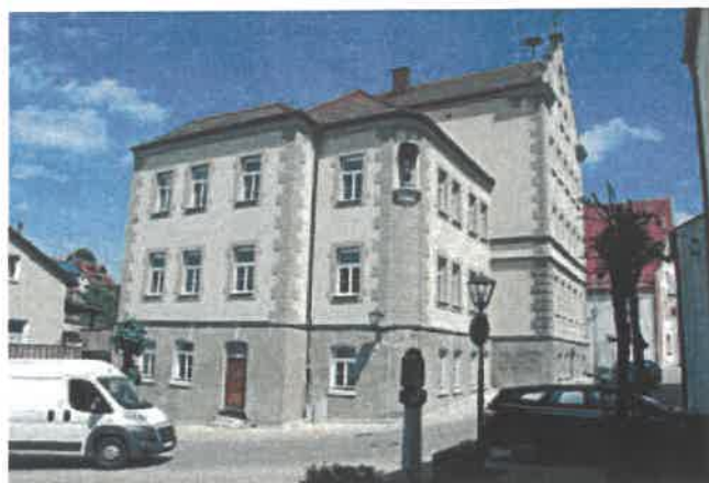
Die Außenfassade hat bis auf das Erdgeschoss bereits seinen neuen Anstrich.
