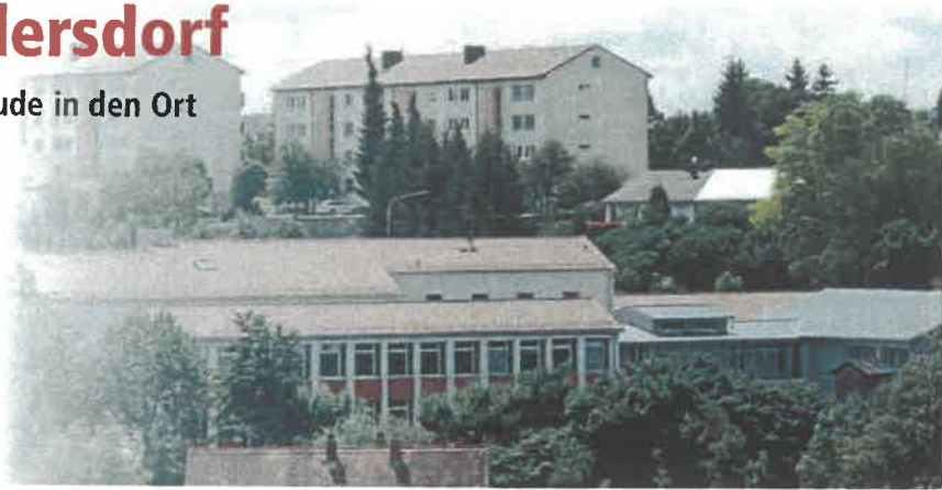
Blick auf die sanierte Schule im Jahr 2008 vom gegenüberliegenden Mühlberg aus. Fotos: az
