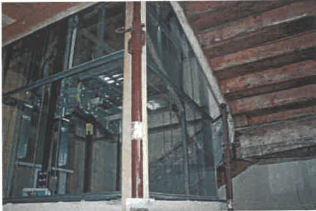
Blick auf dem betriebsbereiten Aufzug und einem Teil des Treppenhauses. Das Treppenhaus muss nunmehr doch erneuert werden.
