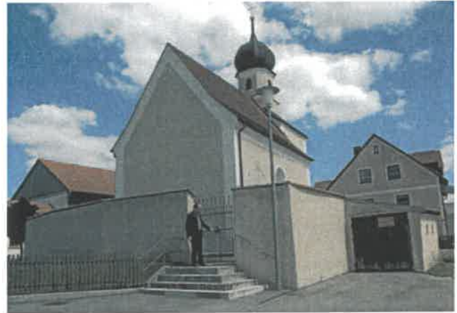
Die Kirche in der Ortsmitte von Thannhausen. An der Westfassade (im Vordergrund) sind auch einige Ausbesserungen nötig. Der kleine Anbau rechts an die Kirchhof- und Friedhofsmauer dient als Geräteraum für die Feuerwehr. Dieser wird bald verschwinden. An der Südseite ist auch die Sonnenuhr zu erkennen. Fotos: az
