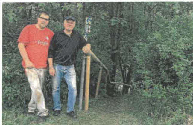
Der Arbeitseinsatz von Voler Drätzl (links) und Eberhardt Dirtheuer (rechts) spielte sich auf der Höhe des Parkplatzes vom Grillhäusl in Sollern ab. Dort erneuerten sie den beschädigten Handlauf. Foto: privat
