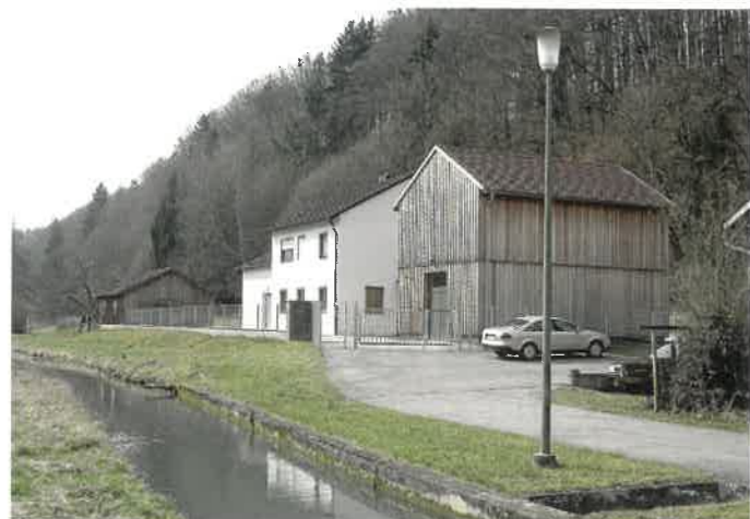
Das Holzvertäfelte Haus an der Kohlmühle, in dem sich die Aktivkohle-Filteranlage befindet.
