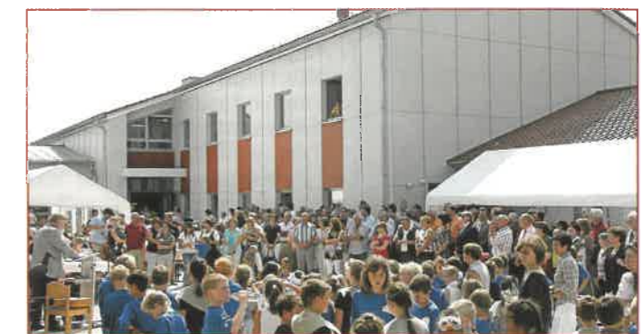
Die Grundschule Sandersdorf: Der Erhalt ist auf Jahre gesichert. Die Gebäude wurden mit Kosten von rund drei Millionen Euro erst vor wenigen Jahren umfassend saniert.
