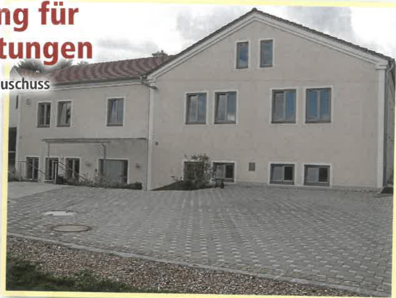
Zuletzt wurde die Pflasterfläche, die Außenüberdachung und ein Treppengeländer auf der Ostseite des DG-Hauses Mendorf gefördert. Das Bild zeigt den Bereich nach der Fertigstellung. In Zukunft kann für solche und ähnliche Maßnahmen mit einem einheitlichen Zuschuss von 22,5 Prozent seitens der Gemeinde gerechnet werden.
