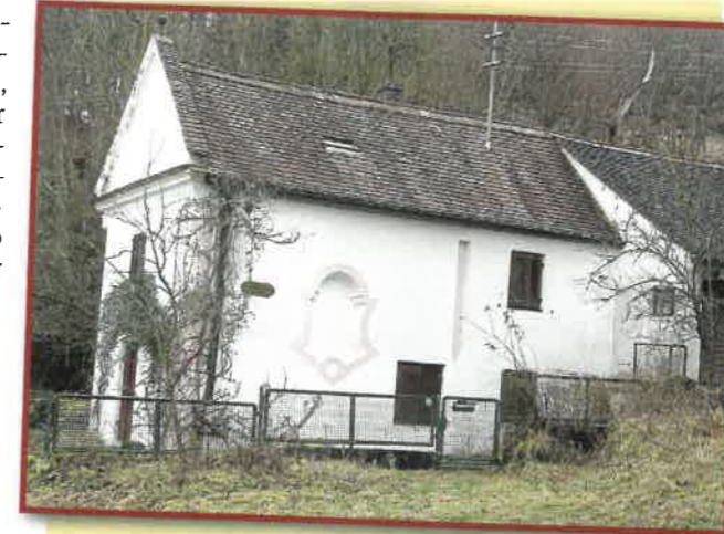
Ehemalige Hochzeitskapelle der Gräfin von Topor Morawitzki und des Fürsten von Porcia. Seit 1838 urkundlich profaniert und als Wohnhaus aufgeführt
