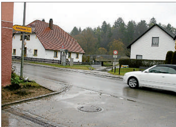
Der neuralgische Punkt soll nunmehr umgebaut werden: Die Einmündung der Straße aus Richtung Hattenhausen in die Hauptstraße von Hexenagger. Das kleine Gefälle dahinter führt zur Flutmulde. Foto: Binder
