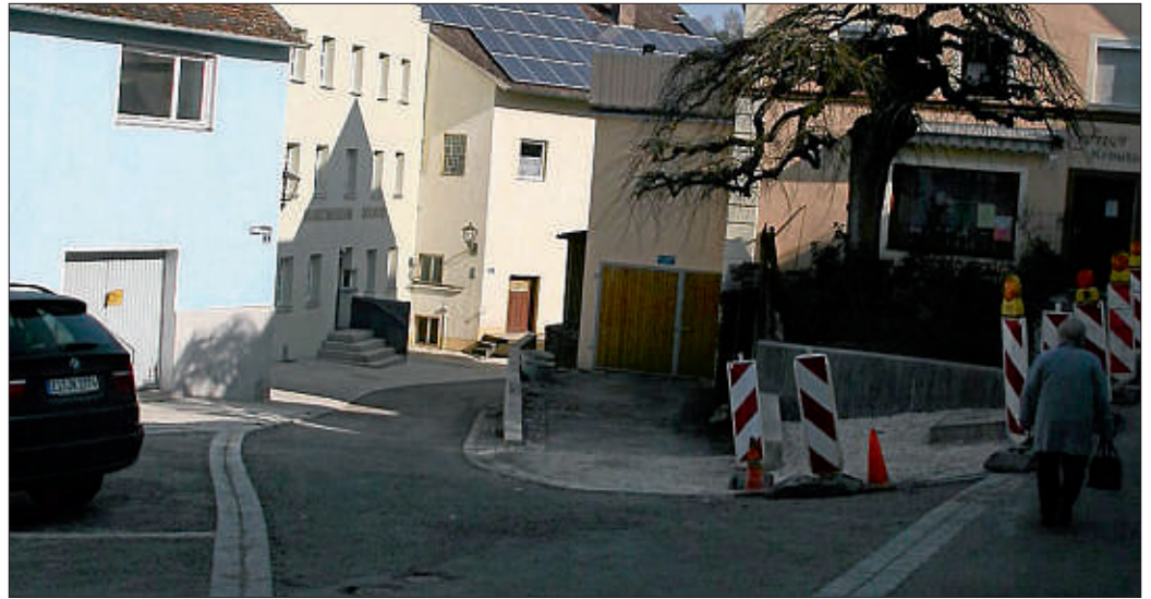
Der Bauabschnitt I (Bild) konnte zum Großteil noch im Vorjahr abgeschlossen werden. Im Vordergrund die Einmündung in den Marktplatz, im Hintergrund in der Mitte das neue Marktuseum. Foto: Binder
