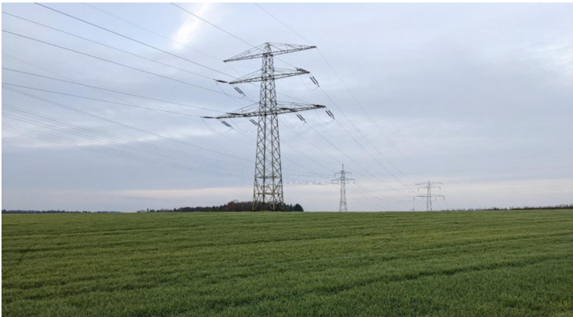
Abb.: Blick von Südost in Richtung Nordwest auf die Teilfläche 4 (eigene Aufnahme 12/2022)
