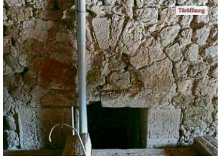
Die Türöffnung über der Sakristei durchbrach die Südwand des Chorraums in ihrer vollen Stärke. Zum Kircheninneren ist sie jetzt zugemauert. Hinter dem Plastikrohr ist in der Leibung ein ebenfalls zugemauerter Aufgang zu erkennen, der von ebener Erde bis auf eine Höhe von etwa vier Metern hinaufführt. So wurde ein Obergeschoss erschlossen, das auf der einen Seite in den heutigen Chor hinein ausgriff und auf der anderen Seite ein Nebengebäude an die Kirche anband.
