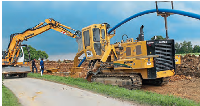
Von Thannhausen kommend wurde eine neue Fernleitung über Neuses und Pondorf zum Wasserturm bei Winden gebaut.
