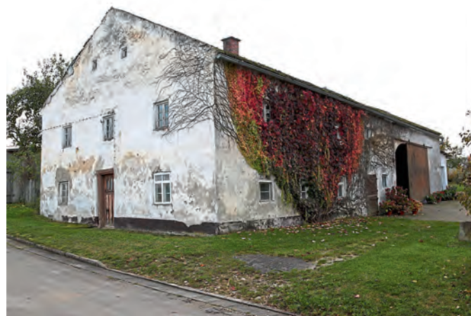
Eventuell wurden vom Besitzer dieses Anwesens einst der Zehent und die Vorräte der Steinsdorfer Muggenthaler gelagert und verwaltet.
