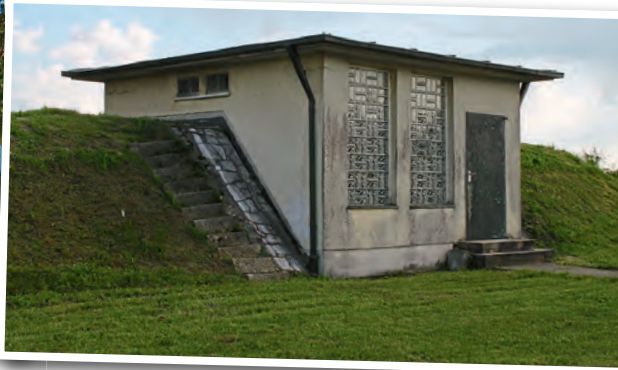
Das Pumpwerk (links) und der Hochbehälter (rechts) an der Kelheimer Straße werden nach dem Umschluss auf das neue Leitungsnetz außer Betrieb gestellt.
