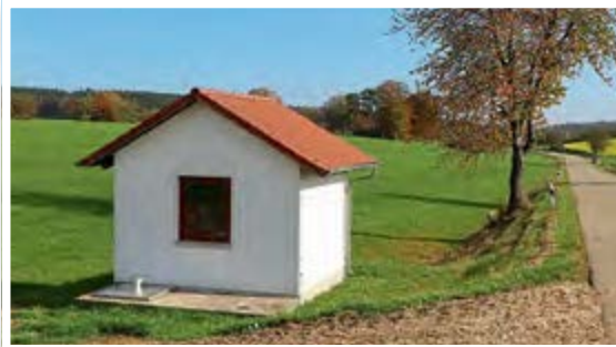
Das Pumpenhaus in Thannhausen wurde renoviert und mit einer neuen Technik ausgestattet.
