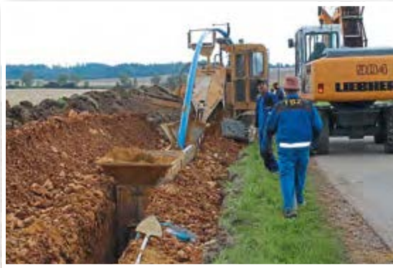
Mit Spezialmaschinen wurden die Rohre verlegt, eingesandet und anschließend wurde der Graben wieder zugefüllt.
