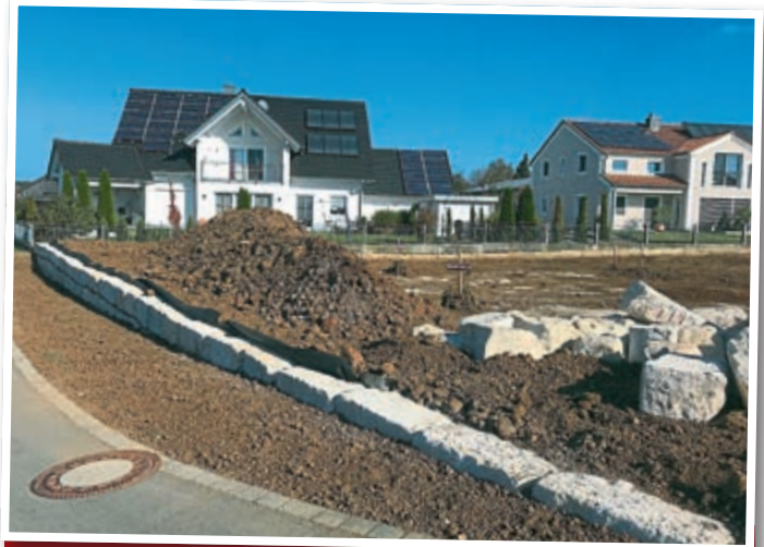
Rege Bautätigkeit herrscht im Süden Tettenwangs „Am Südhang“, bei dem zwei Einfamilienhäuser fertiggestellt und zwei weitere im Frühjahr mit dem Bau beginnen.
