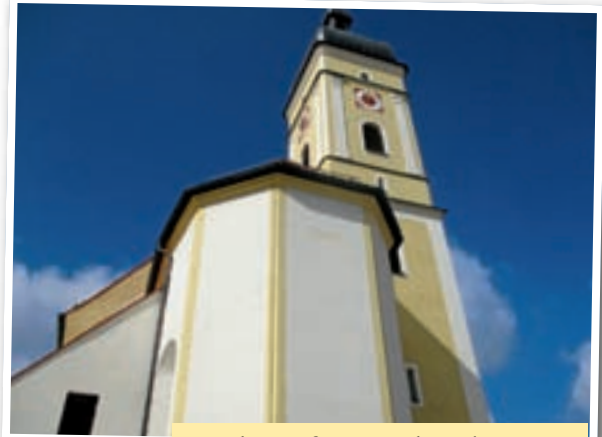
An der Außenseite des Altarraums steht die Jahreszahl 1698 als Jahr des Baubeginns der Barockkirche.
