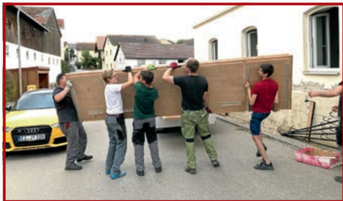
Recht fleißig waren etwa drei Dutzend Tettenwanger beim „Entkernen“ des alten Schulhauses.
