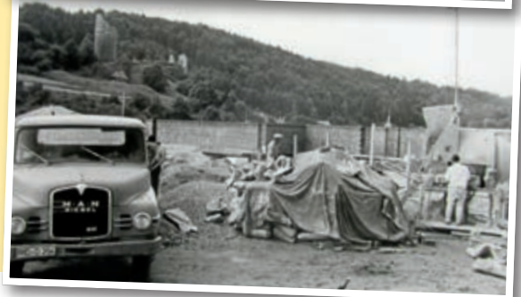
Bild unten: Die Roh- bauarbeiten im Herbst 1966 schreiten zügig voran.
