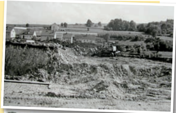
Bild oben: Erdaushub auf dem Schindlberg im August 1966, mit den damaligen Maschinen eine mühe- volle, lang- wierige Angelegen- heit.
