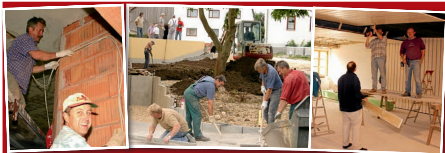
Im Steinsdorfer Dorfgemeinschaftshaus stecken viele Stunden ehrenamtliches Engagement, sowohl im Innenbereich als auch in den Außenanlagen. Von der Planung bis zur Einweihung war die Entstehung des neuen Zentrums des Ortes eine gewaltige Gemeinschaftsleistung, die die Steinsdorfer mit Bravour bewältigten.
