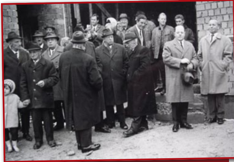
Bürgermeister Riepl (2.v.r.) und Architekt Schretzenmayr (1.v.r.) beim Richtfest der Volksschule 1966
