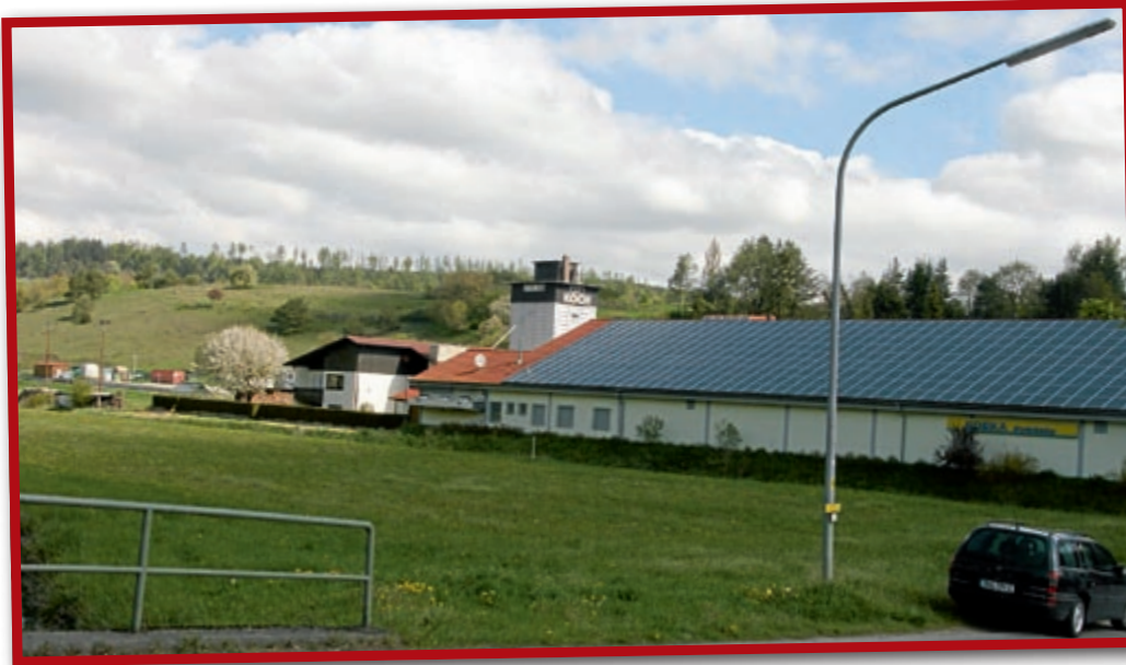
Die Südseite des Supermarktes – hier soll im Anschluss die Erweiterung erfolgen. Links davon das Wohnhaus. Ganz links am Bildrand sind Einrichtungen des Wertstoffhofs zu erkennen. Das Gelände im Vordergrund gehört zur Schambachbrücke am Galgenberg. Im Hintergrund das Hochgebäude vom Lagerhaus Koch. Foto: az
