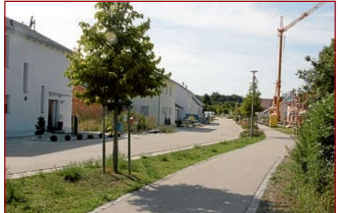
Die meiste Bautätigkeit herrschte 2015 wohl im Gebiet „Bahnhofplatz“ Sandersdorf. Alle Häuser sind weitgehend hochgezogen, ein Großteil bewohnt. Es zogen hier auch etliche Neubürger ein. Fotos: az
