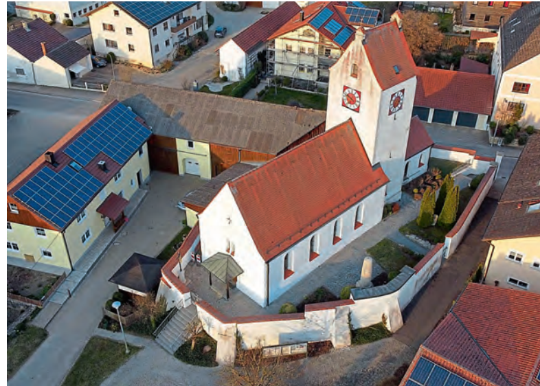
Außenansicht der Filialkirche St. Walburga in Laimerstadt.
