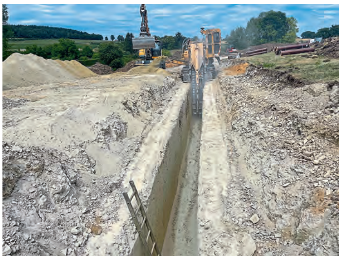
Bodenfräsarbeiten im Baugebiet Altmannstein
