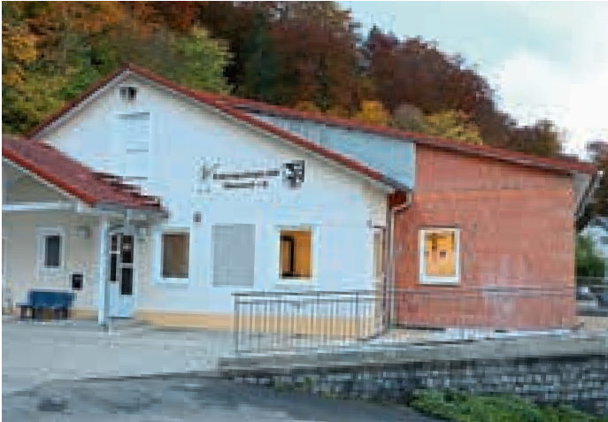
Das Schützenhaus der SG 1560 Altmannstein wurde nach Norden hin erweitert.
